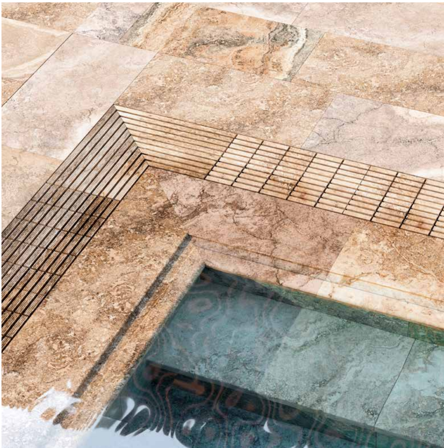
Bermeo. Borde técnico y rejilla cerámica.
